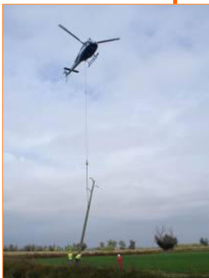
Dépose de poteaux électriques après enfouissement des lignes en Camargue par EDF
