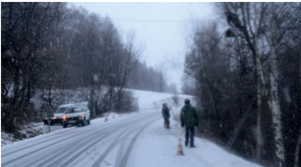
Installation de l'écuroduc sous la neige © Marc PROVOST
