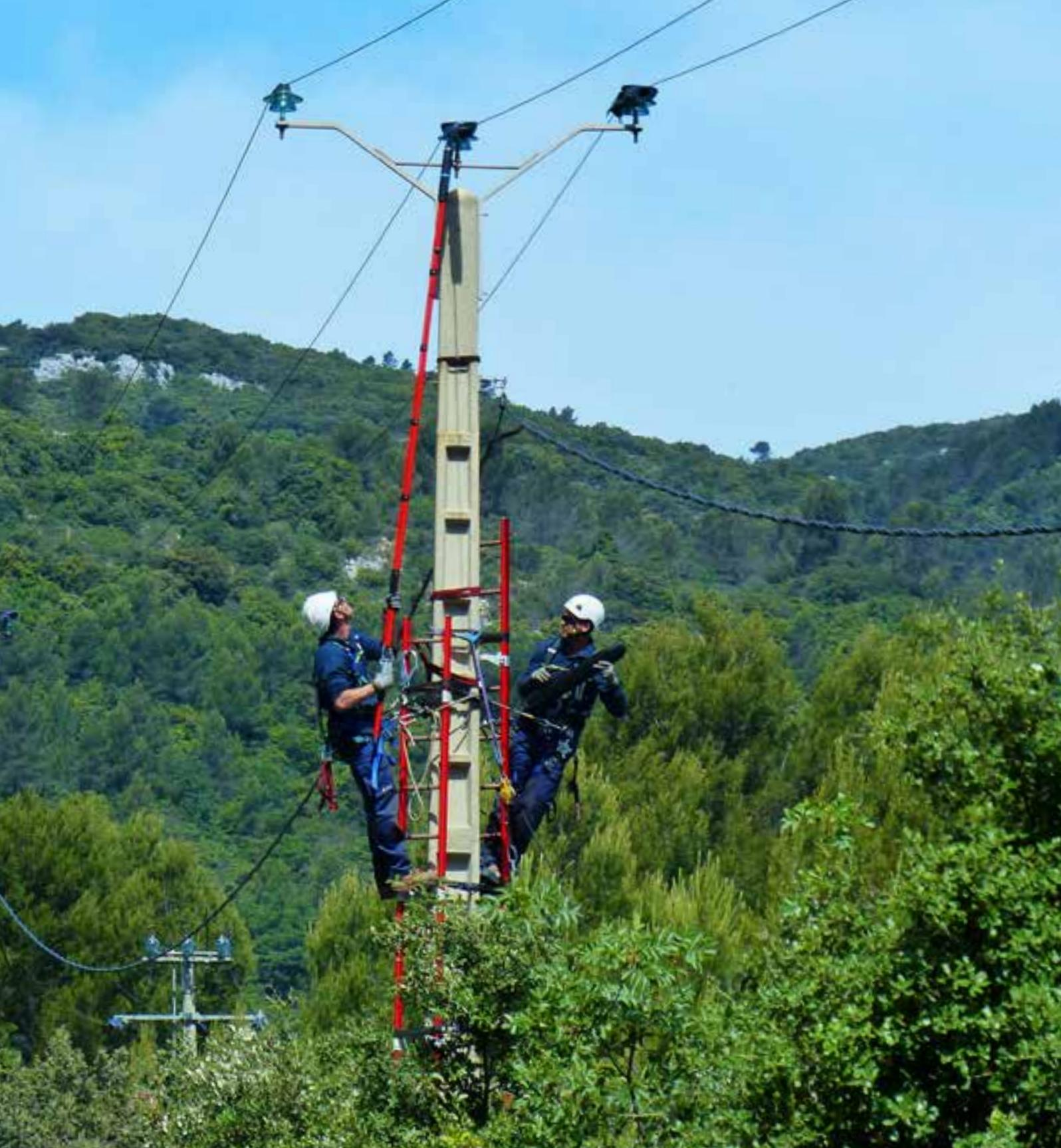
Pose d'une protection avifaune sur une ligne moyenne-tension par ERDF
