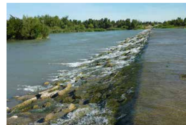
Seuil sur la Durance à Châteaurenard, Bouches-du-Rhône. © Benjamin Kabouche
