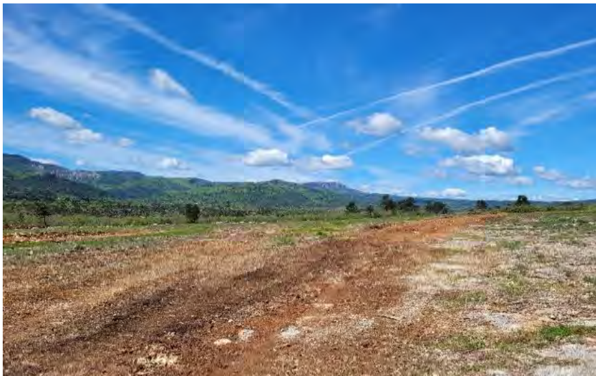
Figure 10 : faciès de défrichement et terrassement récent sur la future zone d'extraction de la carrière du Caïre de Sarrasin
