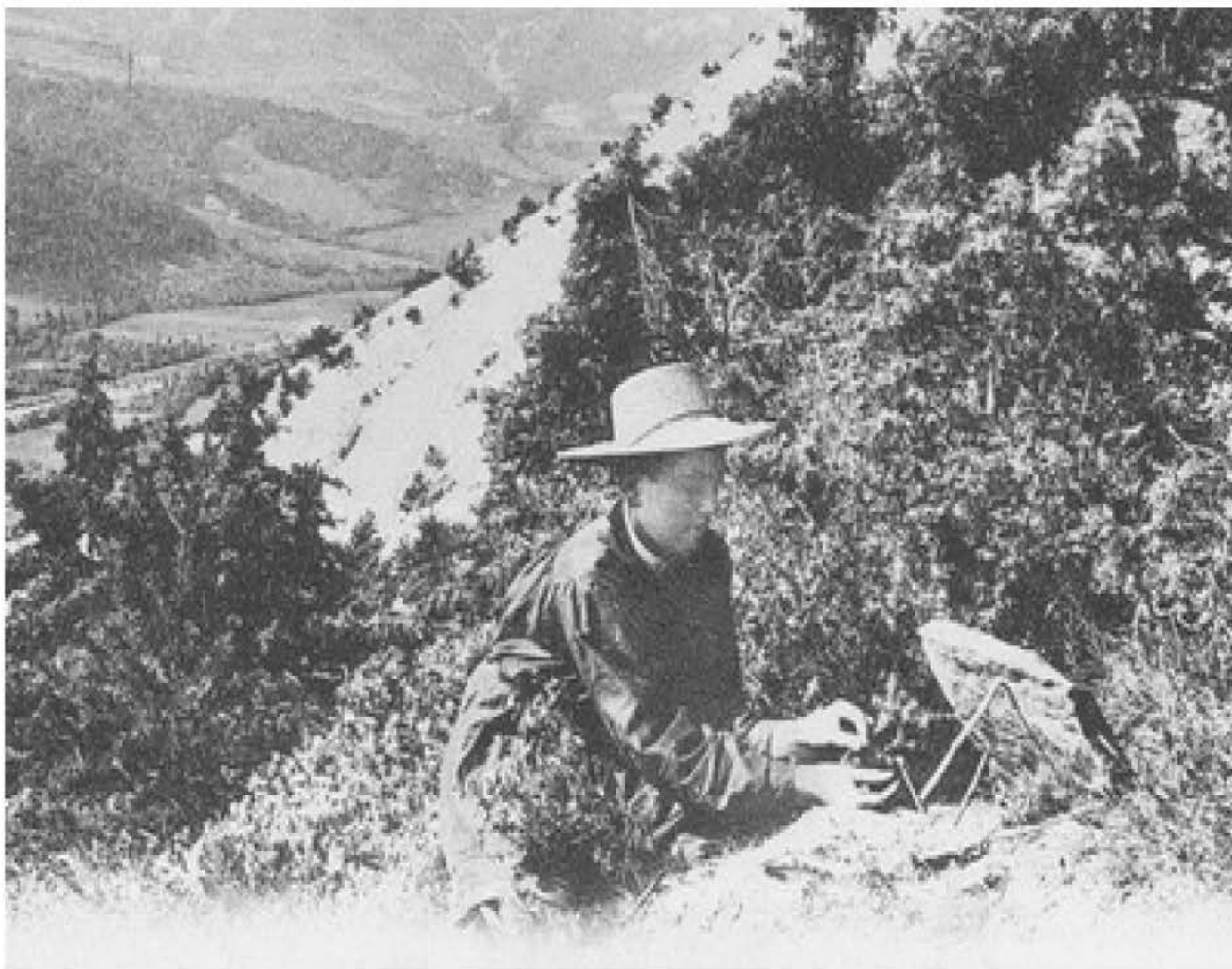
Pose des lecques aux environs de Barcelonnette
