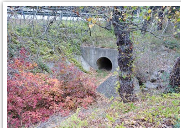
Ouvrage n°10, amont © LPO PACA
