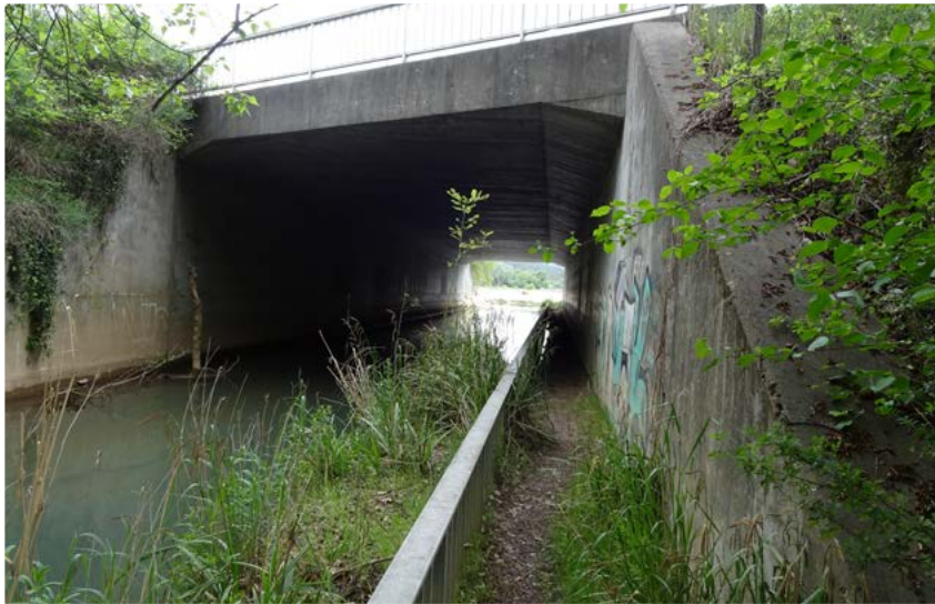
Ouvrage n°8, amont © LPO PACA
