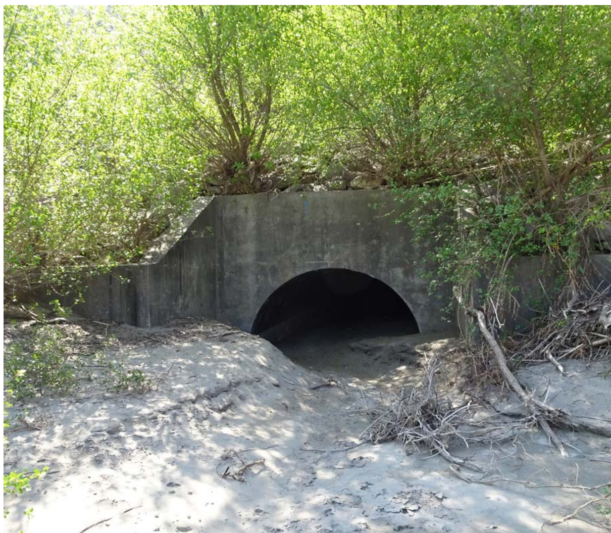
Buses ayant perdues la moitié de leur hauteur utile par ensablement © LPO PACA
