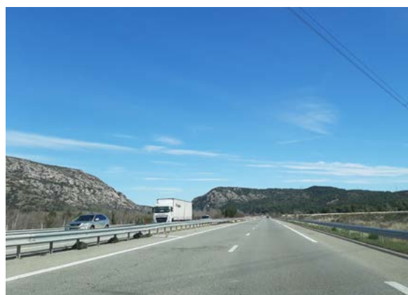
A51 au niveau de Saint-Paul-lès-Durance © LPO PACA
