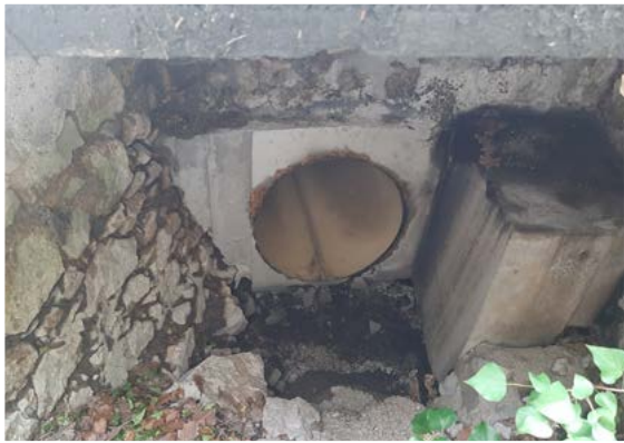
Ouvrage n°4, amont © LPO PACA
