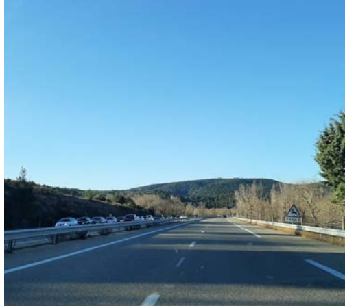
A51 au niveau de Saint-Paul-lès-Durance © LPO PACA
