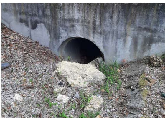
Ouvrage n°6, amont © LPO PACA
