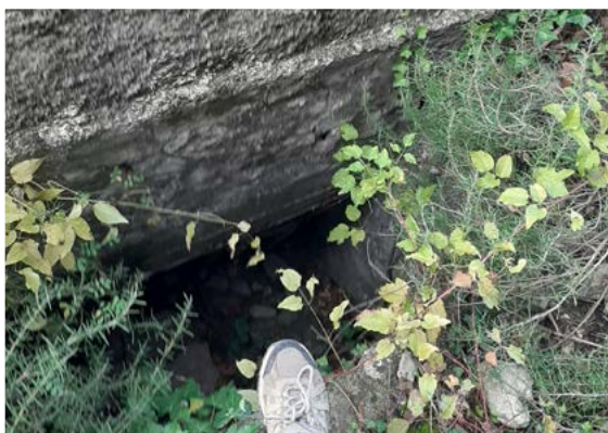
Ouvrage n°6, amont © LPO PACA
