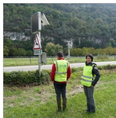
Signalisation couplée à un système de détection
