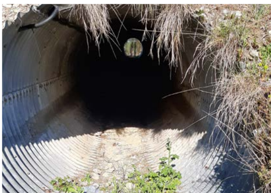
Ouvrage n°1, amont © LPO PACA
