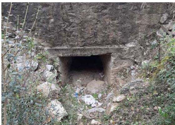
Ouvrage n°5, amont © LPO PACA
