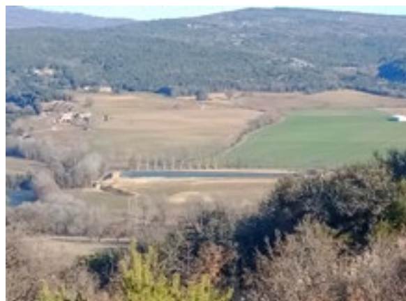
Vue de loin sur une retenue en plaine © LPO PACA
