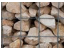
Gabion en pierre locale
