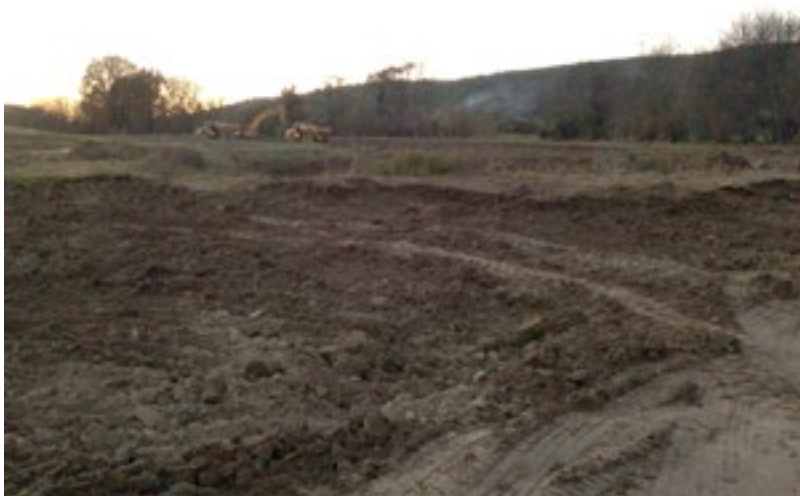
Réalisation des travaux de création d'une retenue en période automnale © Chambre d'Agriculture des Alpes de Haute-Provence
