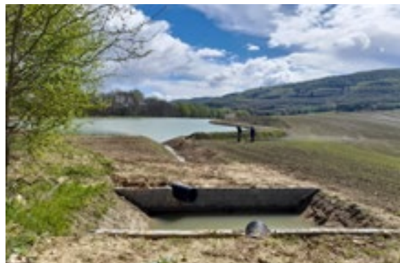
Bassin de décantation © LPO PACA
