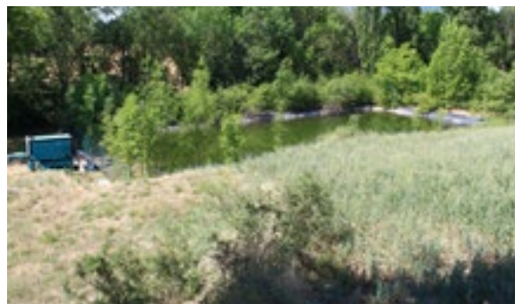
Retenue implantée sur une courbe de niveau en contre haut du ruisseau d'alimentation
