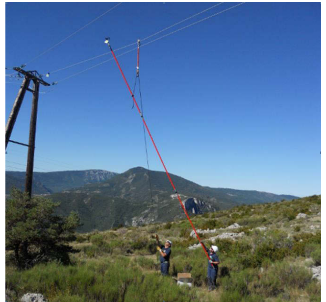
Firefly I – Focalise l'attention des oiseaux sur la lumière et le mouvement
