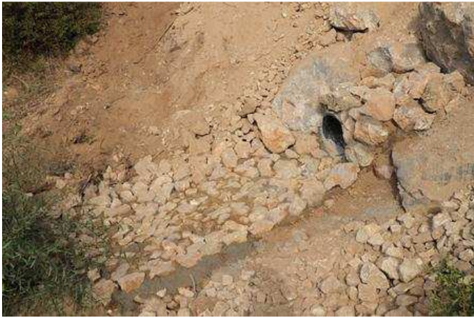
Canalisation : 9 et 10 septembre © L. Rouschmeyer
