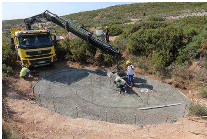
Coulage du béton – 8 septembre © L. Rouschmeyer
