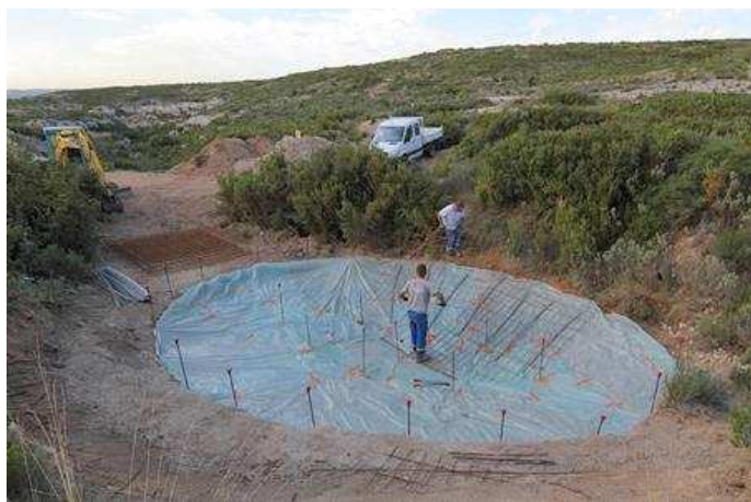
Pose des treillis – 5 septembre © L. Rouschmeyer
