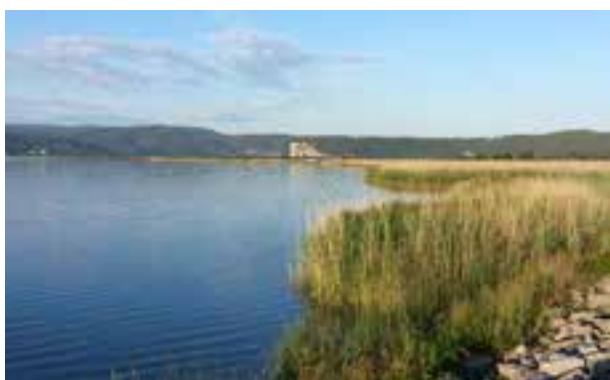
Retenue d'eau de Cadarache © Amine FLITTI
