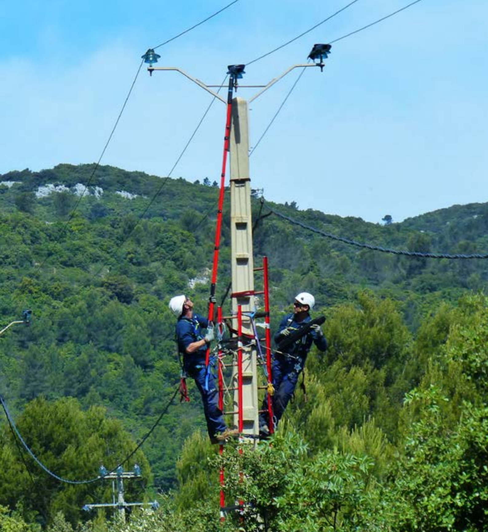
Pose d'une protection avifaune sur une ligne moyenne-tension par ERDF © Benjamin KABOUCHE
