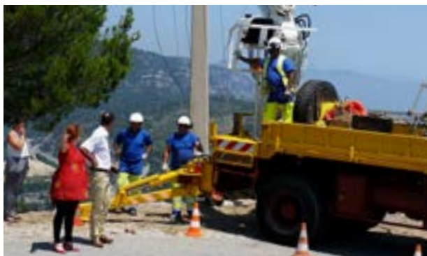
Chantier de suppression des lignes électriques moyenne-tension au fort de la Revère dans les Alpes-Maritimes © LPO PACA
