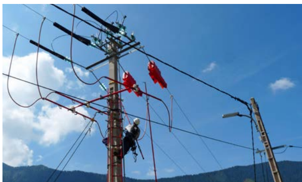
Chantier de neutralisation du risque d'électrocution par Enedis à Valdeblère © Micaël GENDROT
