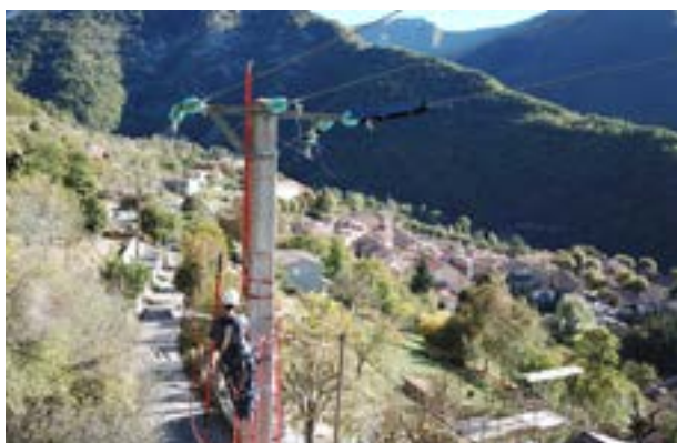
Chantier de neutralisation du risque d'électrocution par Enedis à Moulinet (06) © Enedis
