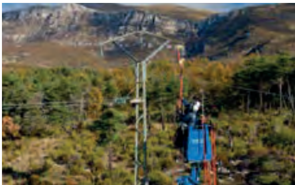
Chantier de sécurisation dans le Verdon © ENEDIS
