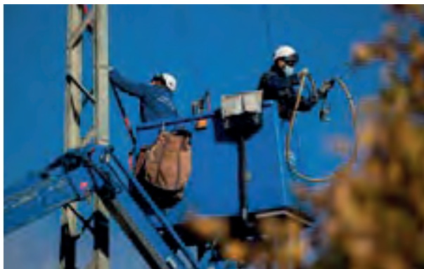
Des techniciens Enedis posent des protections Avifaunes à La Palud sur Verdon © Enedis
