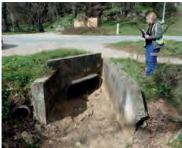
Prospection d'un ouvrage sur le secteur prioritaire n°5, centre Var © Micaël GENDROT
