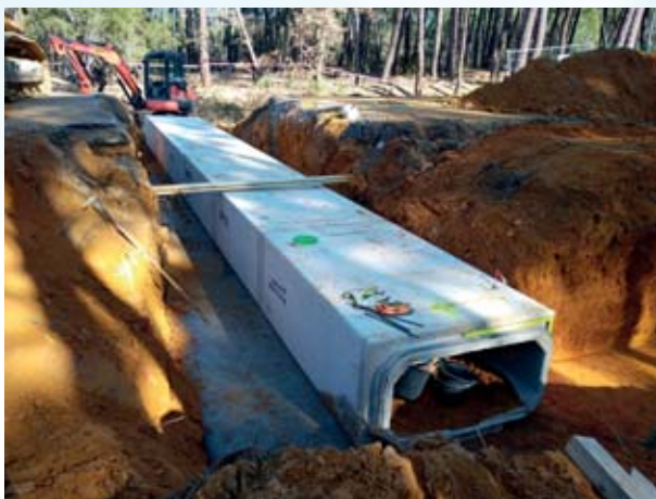
Construction d'un crapauduc à Mormoiron © Nicolas FUENTO
