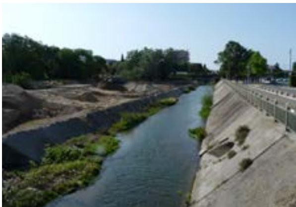
État initial de la Cagne au démarrage des travaux © Micaël GENDROT
