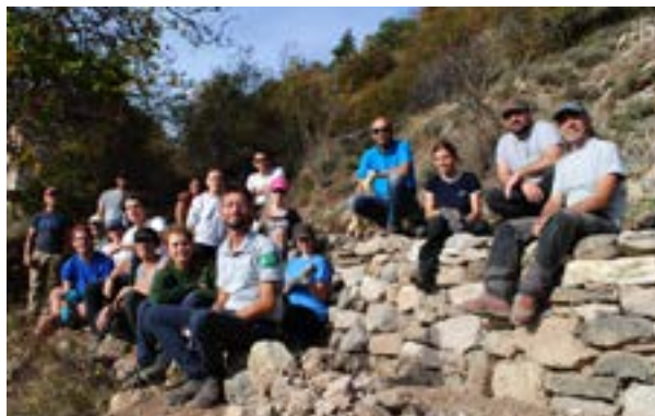
Chantier de rénovation d'un mur en pierres sèches au hameau d'Amen © I. SILVEIRA
