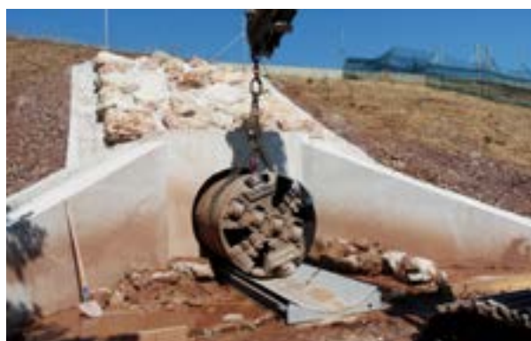
Extraction du micro tunnelier ayant foré le nouvel écoduc sous l'A57 © M. GENDROT
