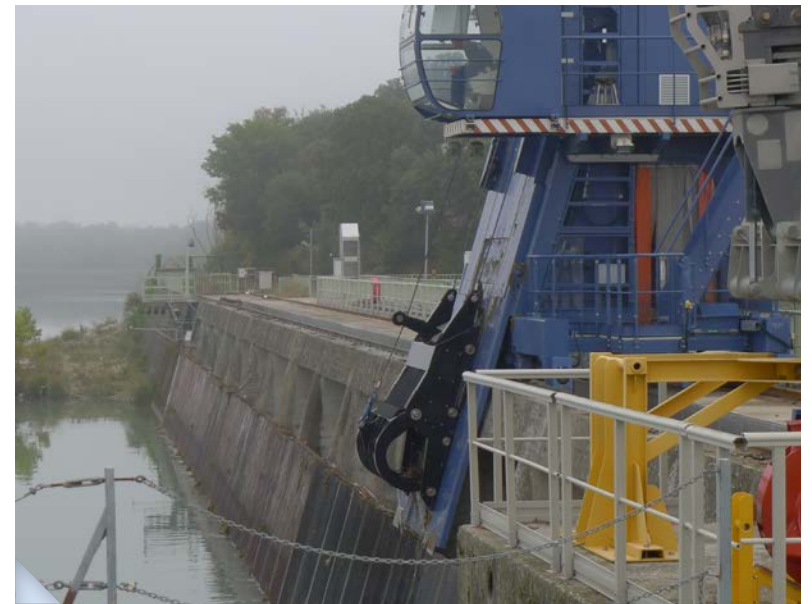
Curage du barrage © Pierre RIGAUX
