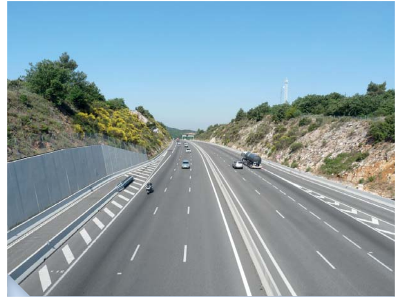
Vue du site du futur ouvrage de Pourcieux © M. Gendrot - LPO PACA
