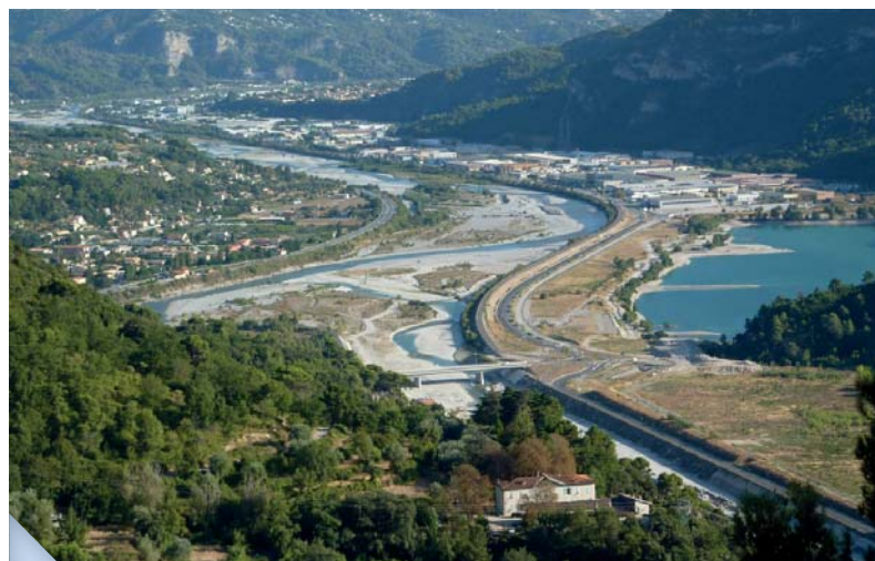
Juxtaposition des infrastructures en fond de vallée créant des obstacles aux continuités © Tangi CORVELER
