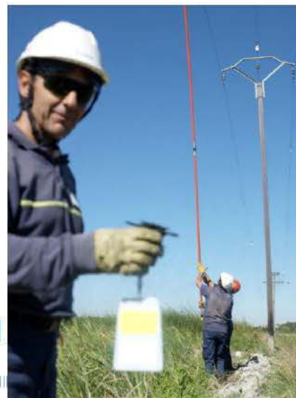
Pose d'une balise au sol
