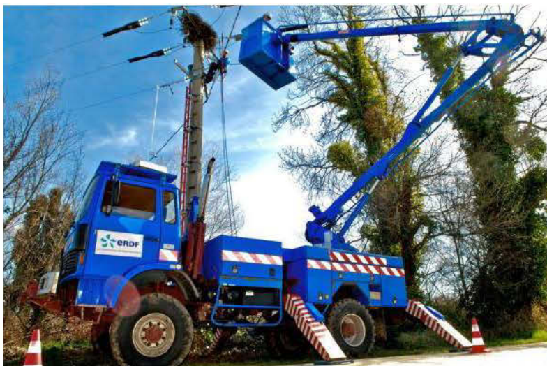
Pose d'un équipement pour les cigognes
