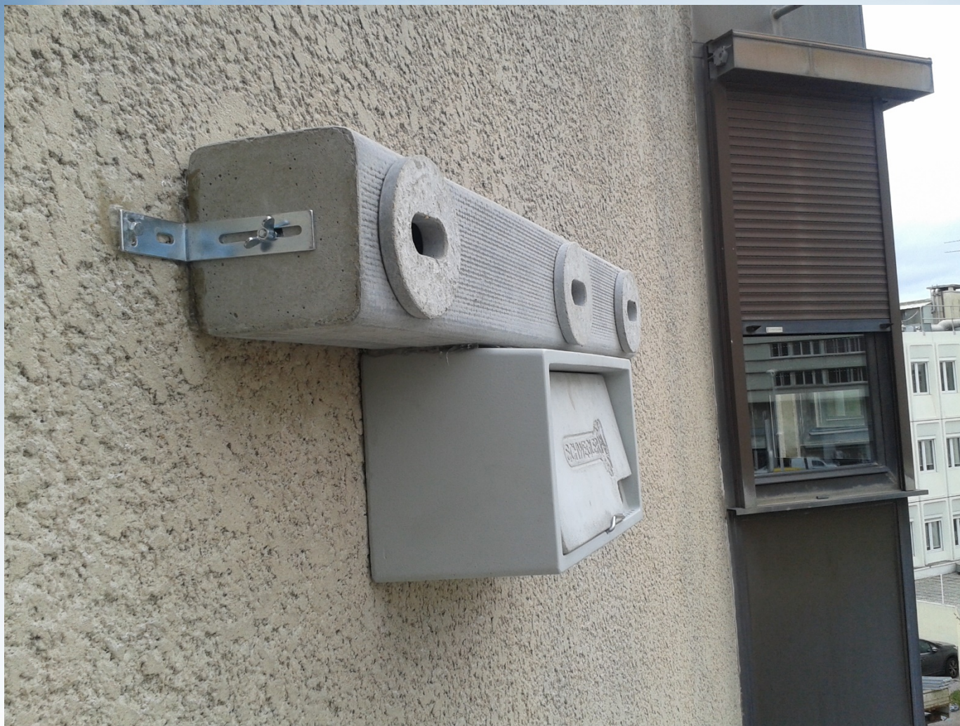
1 NICHROI TRIPLE 17 A ET 1 NICHROI 16 S SCHWEGLER EQUIPE D'UNE CAMERA
