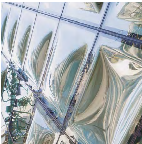
Ces briques en verre bombées sont très réfléchissantes...
