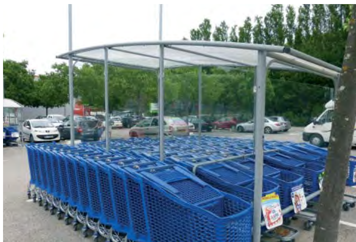
Cet abri pour caddies possède des parois en plexiglas pratiquement invisibles et constitue donc un danger pour les oiseaux.
