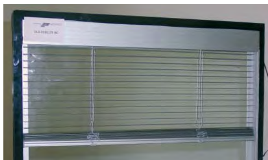
Store intégré dans la fenêtre. Lorsqu'il est baissé, même si les lamelles sont en position horizontale, il protège en partie contre des collisions.
