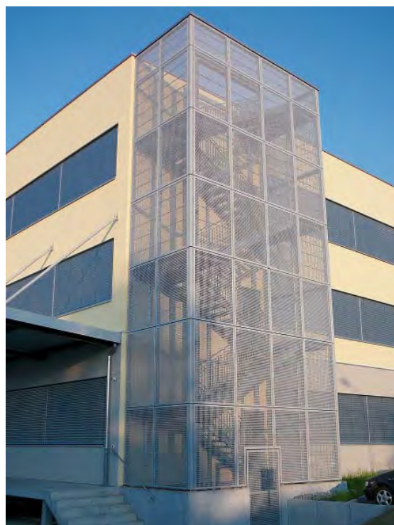
Treillis métallique: laisse passer la lumière, économique et sans danger pour les oiseaux.
