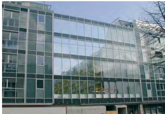
Paroi antibruit et coupe-vent entre deux bâtiments
