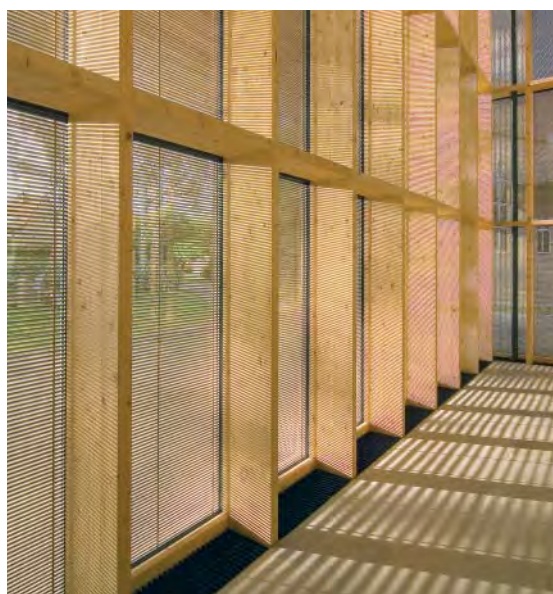
Ce verre isolant avec treillis de bois intégré donne une ambiance très chaleureuse.
