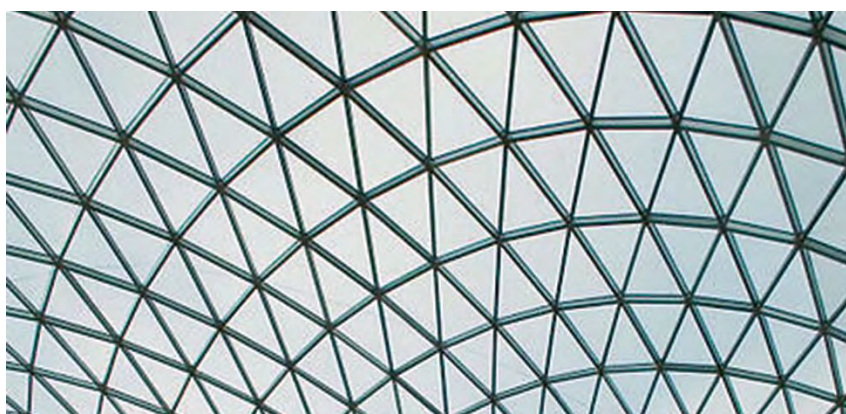
Cette construction structurée en triangles renforce l'effet filet.
