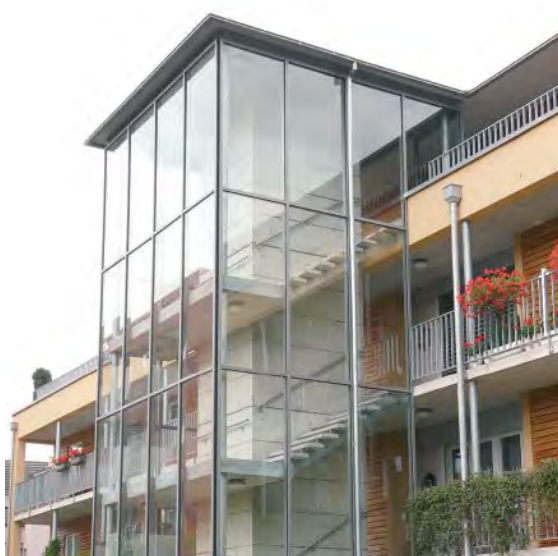
Cage d'escalier en verre
