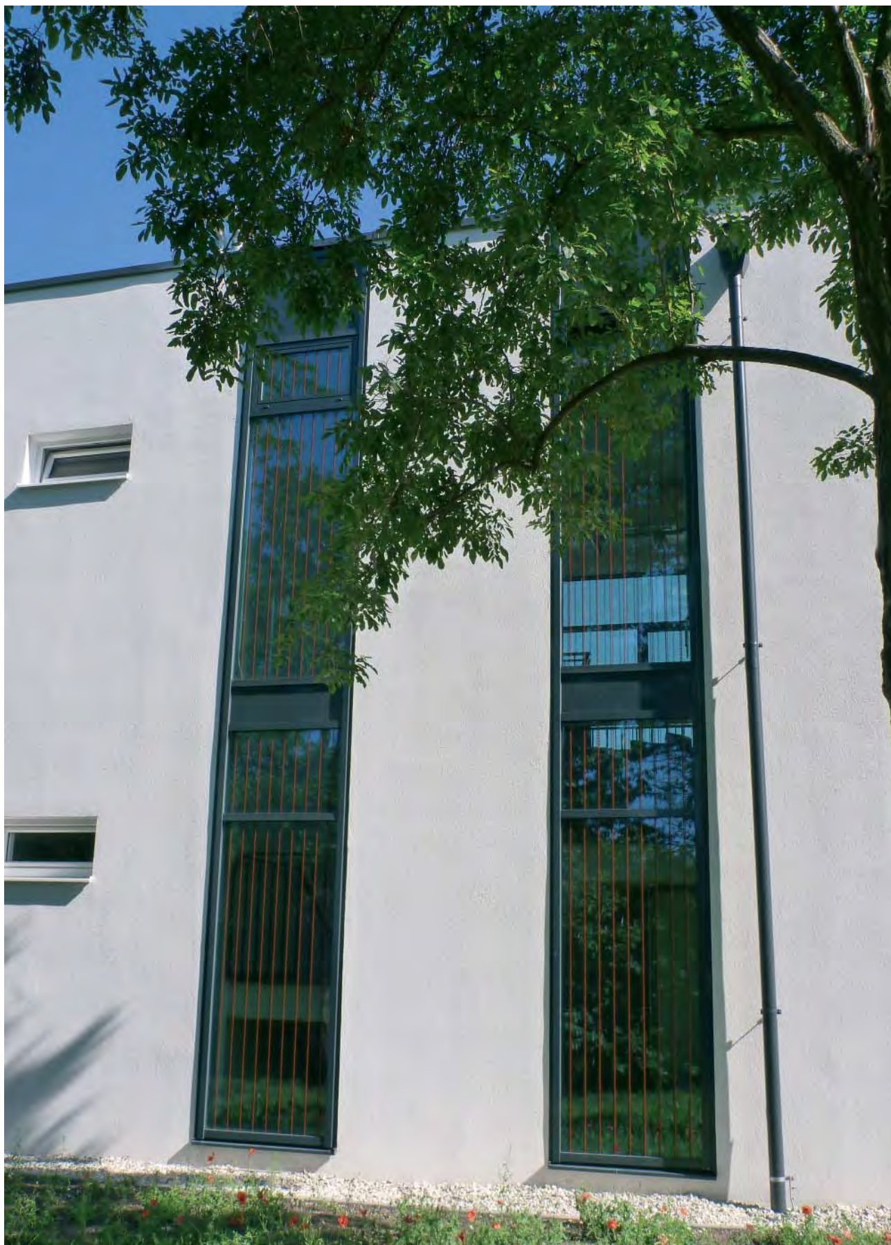
Certains des marquages ayant obtenus de très bons résultats en tunnel de vol sont déjà appliqués sur le verre directement à l'usine. Cela évite de devoir les apposer après coup sous forme de film adhésif.
