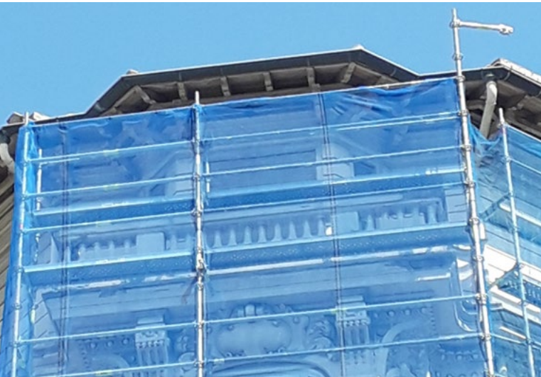
Echafaudages bloquant l'accès au site de nidification © Anne FALENTIN
