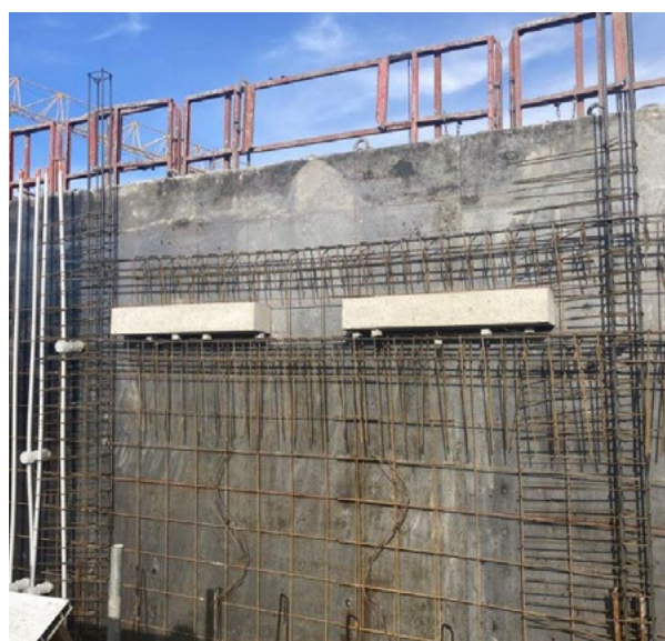
Intégration de nichoirs en béton de bois Nat'H, nouvelle résidence Nice Way, © Yasmine CORAZZANI
