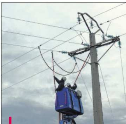
Les ouvriers ont travaillé sur des lignes sous tension.
