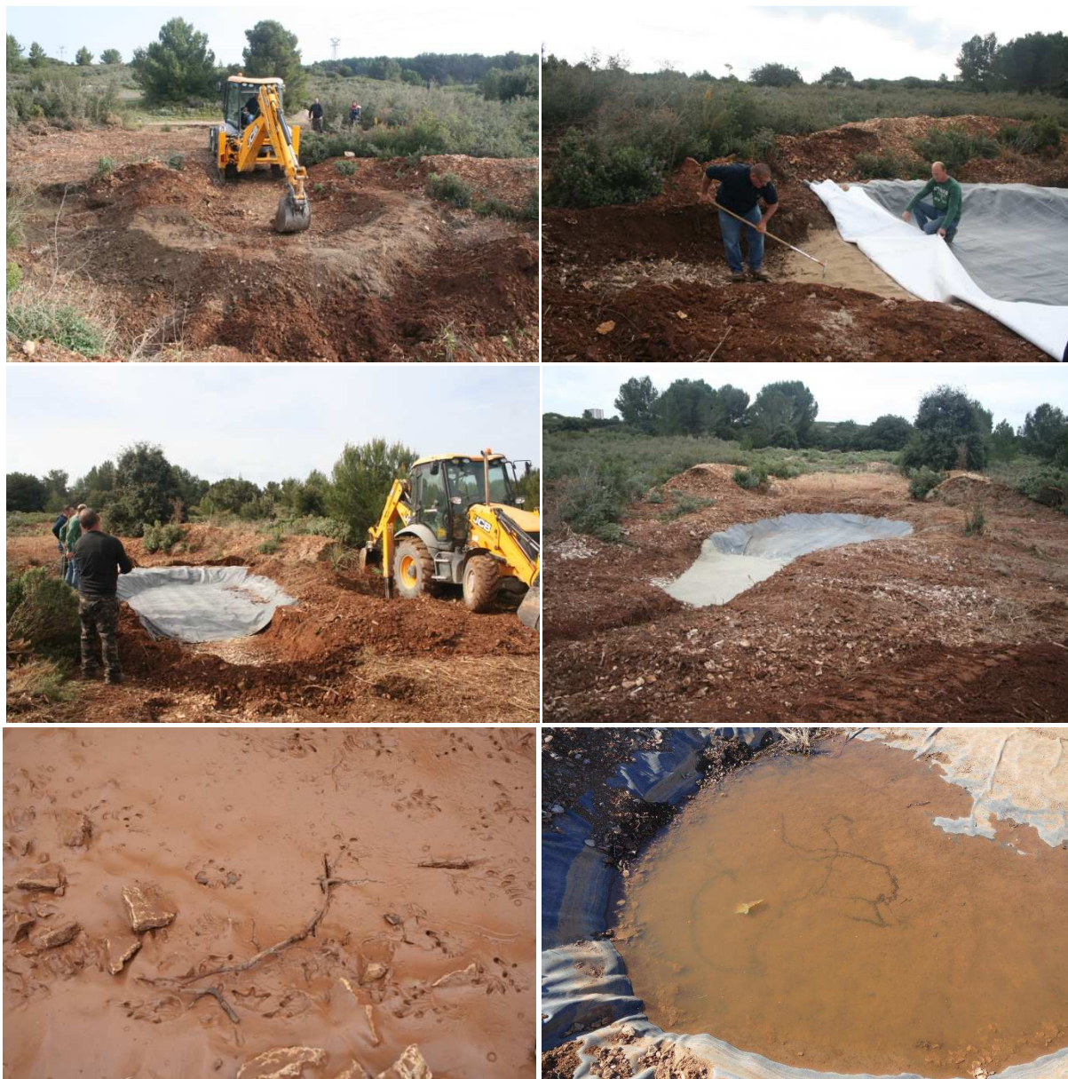
Création de la mare : terrassement ; pose du sable, du géotextile et de la bâche ; enterrement de la bâche et coulage du béton (c) Aurélie Johanet ; Premières traces de pas de Crapauds calamite le lendemain (c) Aurélie Johanet ; Ponte de Crapaud calamite 3 semaines après (c) Nicolas Fuento.
