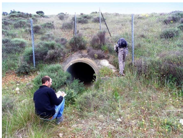
Diagnostic d'ouvrage sur la LGV Méditerranéenne © Aurélie JOHANET ; Exemple d'un croquis sur une fiche de terrain
