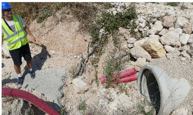
Ouvrage de franchissement inférieur favorable à la petite faune terrestre, pouvant être rendu attractif par la pose d'un substrat © N Fuento
