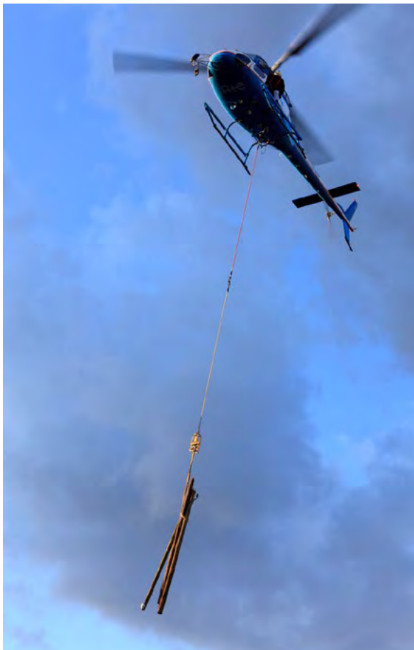
Dépose de ligne © Enedis
