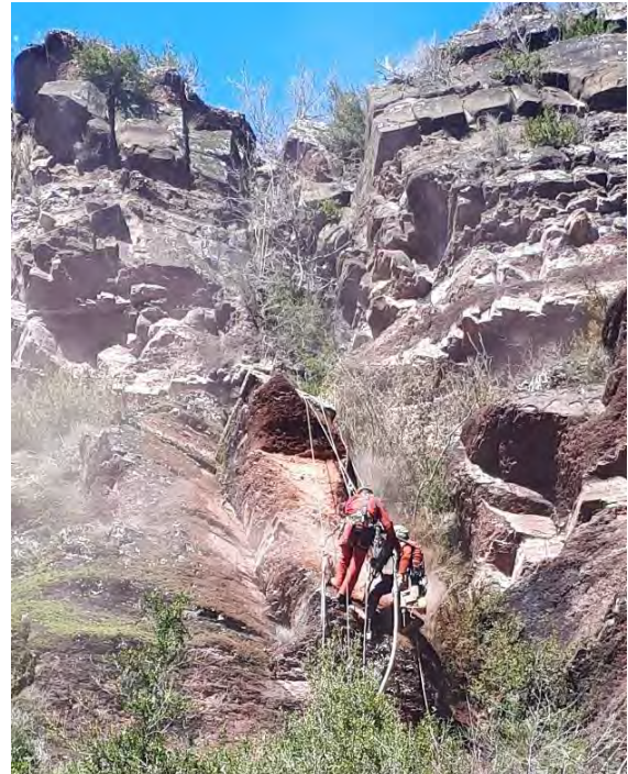
Chantier de sécurisation de falaise © N. Perronnet
