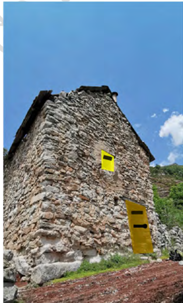
Reconstruction du toit et des murs de l'étage 2. Pose d'une porte fermée avec cadenas sur l'accès O2 (sans chiroptière).
