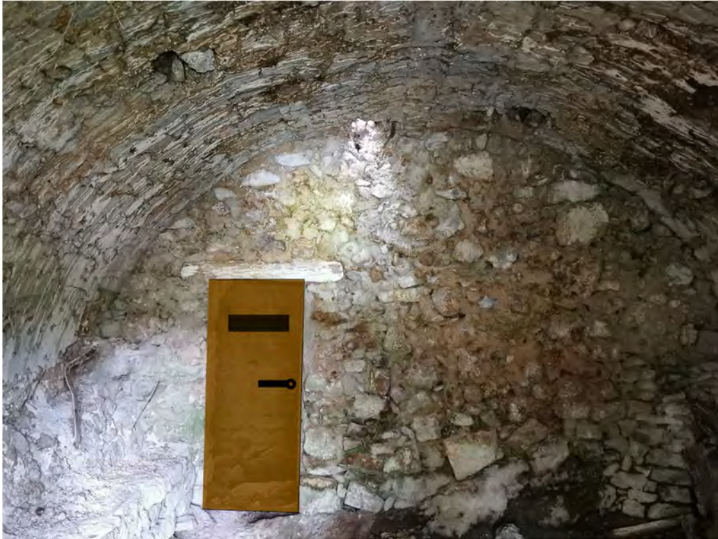
Pose d'une porte séparatrice avec chiroptière entre les deux parties de cave E1-4 et E1-5.
