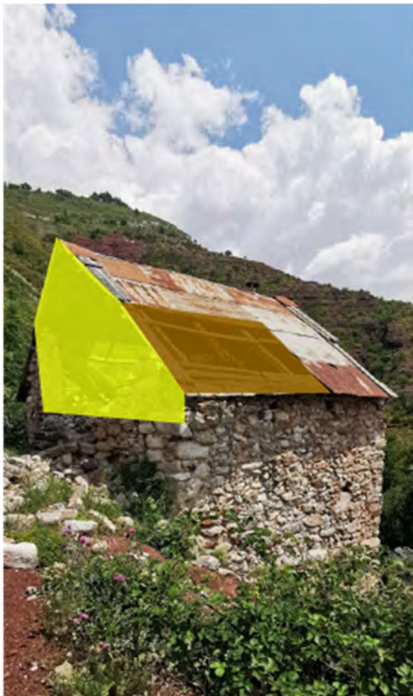
Reconstruction du toit et des murs de l'étage 2. Pose d'une porte fermée avec cadenas sur l'accès O2 (sans chiroptière).
