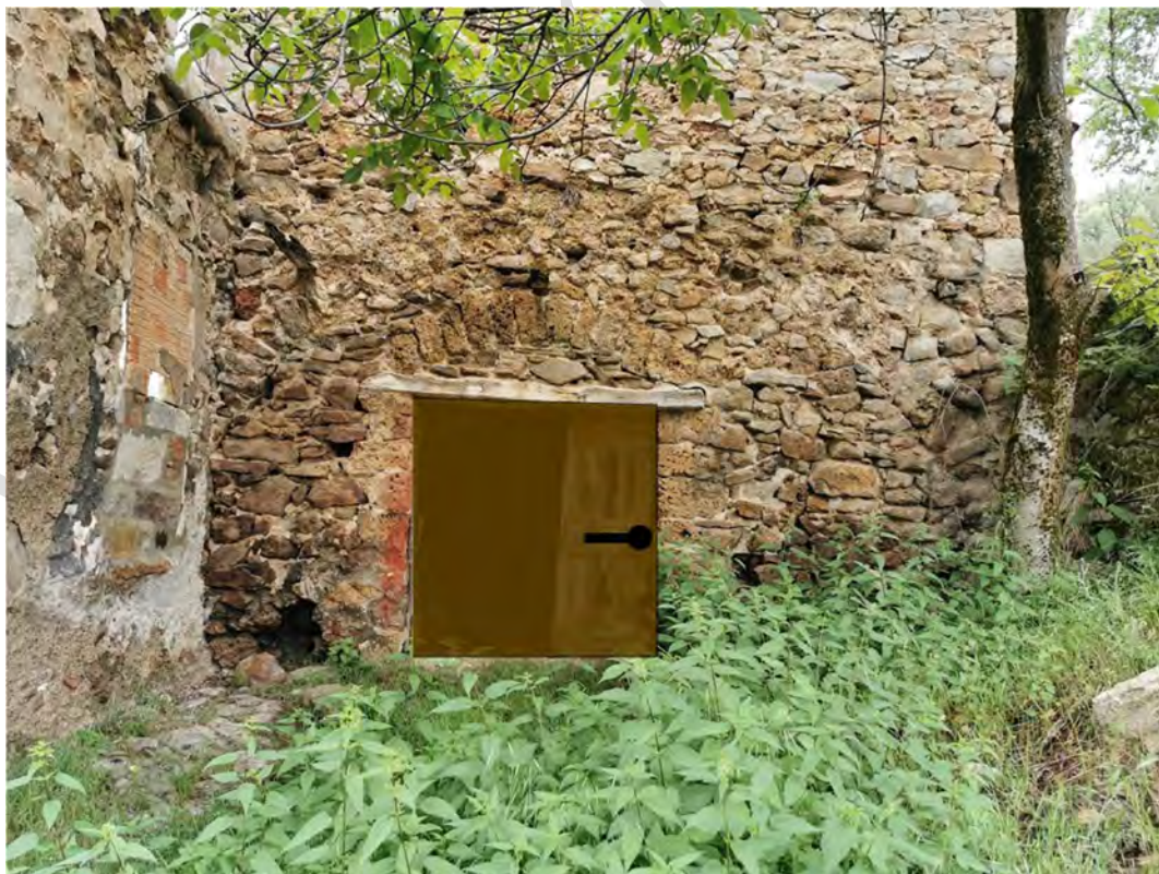
Pose d'une porte fermée avec cadenas sans chiroptère à l'entrée de la cave E1-5.
