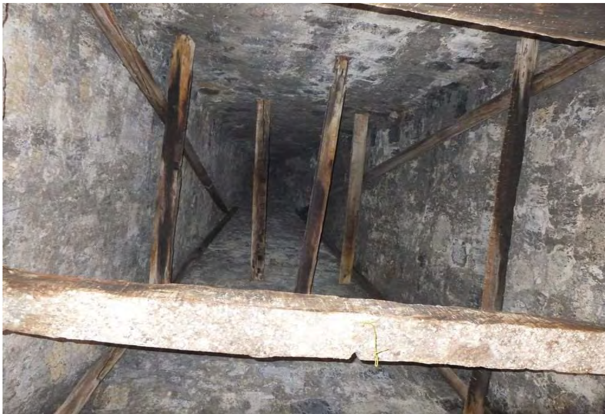
La pointe du clocher lumineuse et fortement ventilée. La présence de poutres à différentes hauteurs pourrait être favorable aux chiroptères pour s'accrocher.
