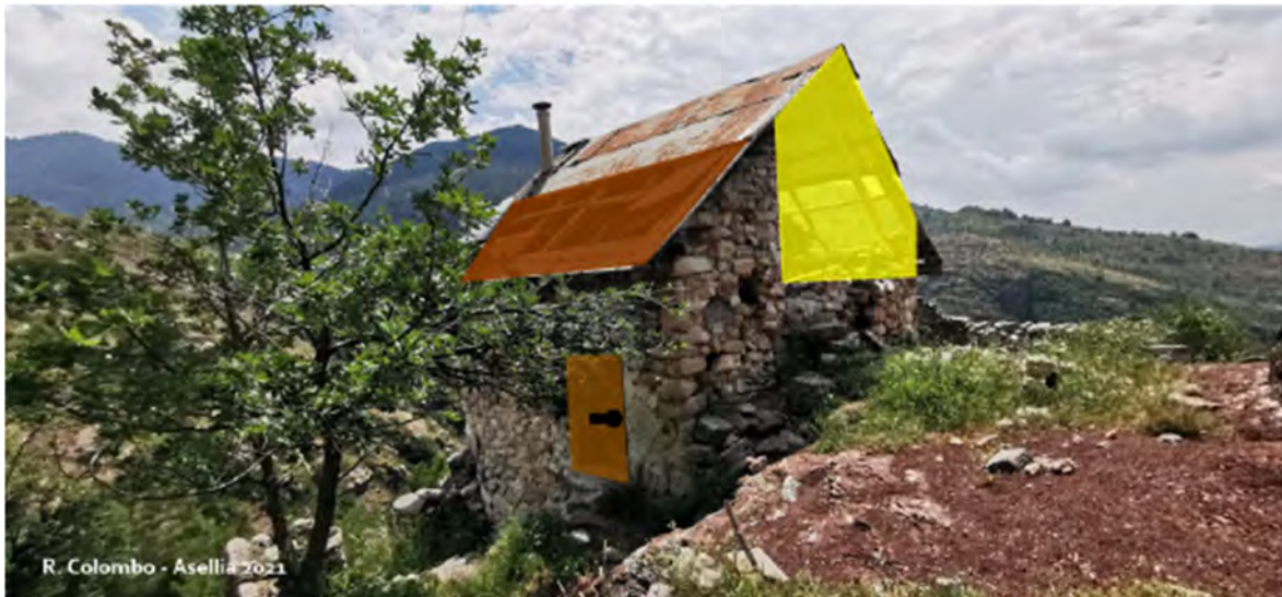
Reconstruction du toit et des murs de l'étage 2. Pose d'une porte fermée avec cadenas sur l'accès O2 (sans chiroptière).
