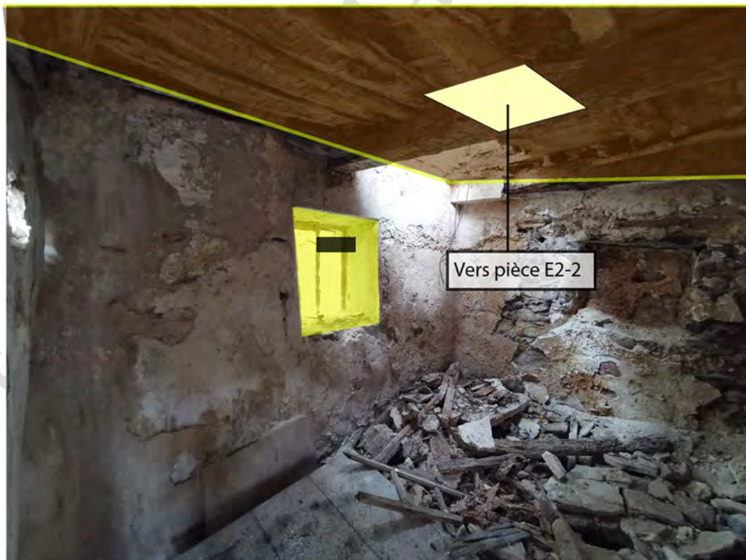
Pose d'un nouveau toit sur la pièce E2-2 (en haut) et mise en place d'un plancher séparateur entre la pièce E2-2 et la pièce E1-3 avec une trappe pour permettre aux chiroptères de circuler (en bas). Fermeture partielle des ouvertures O6 et O11 avec création de chiroptières.
