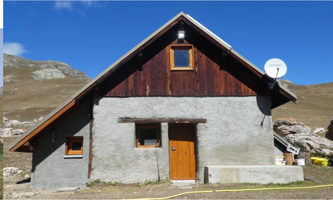
Réception des travaux © C. Dubois
