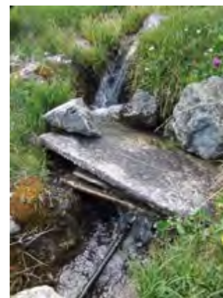
Figure 8 : prise d'eau pour les Partias © V. Fine, LPO
