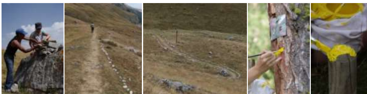
Photo 12 : Cairn et affiche explicative du balisage à l'entrée de la RNR (ci-contre) ; Travaux de construction de cairns, visualisation des sentiers, balisage à la peinture et pose de piquets bois (ci-dessous) © V. Fine / LPO PACA et D. Garde
