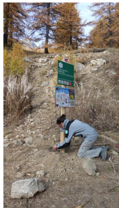
Photo 3 : Remplacement d'un poteau réglementaire © LPO PACA
