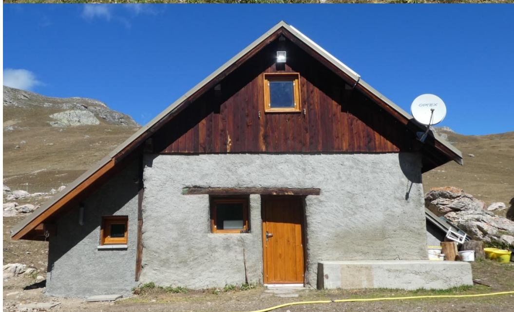
Photo 12 : cabane avant et après réhabilitation © LPO PACA
