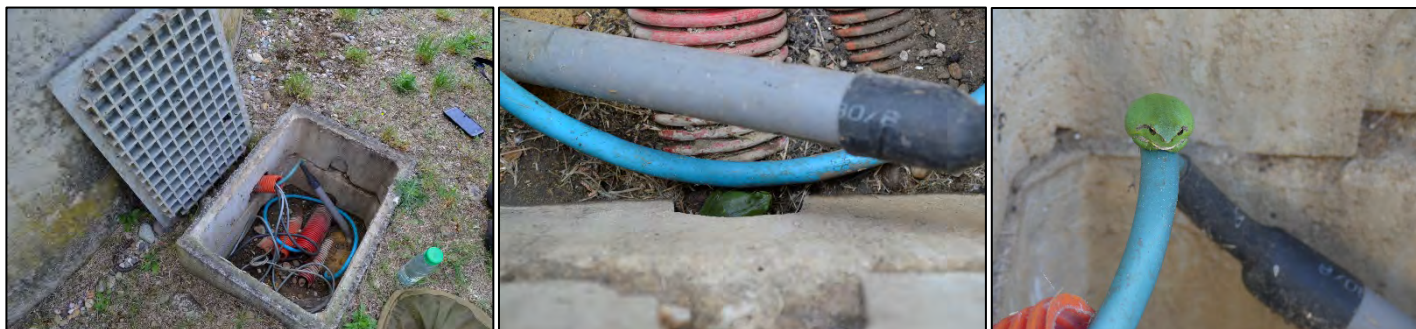
Photos : regard en béton et Rainette méridionale
