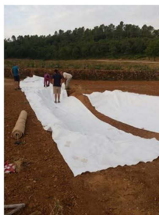
Pose de géotextile
