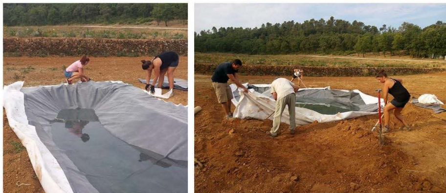
Installation des bâches et pose d'une toile de jute, finition des abords.
