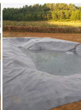
Pose de la bâche
