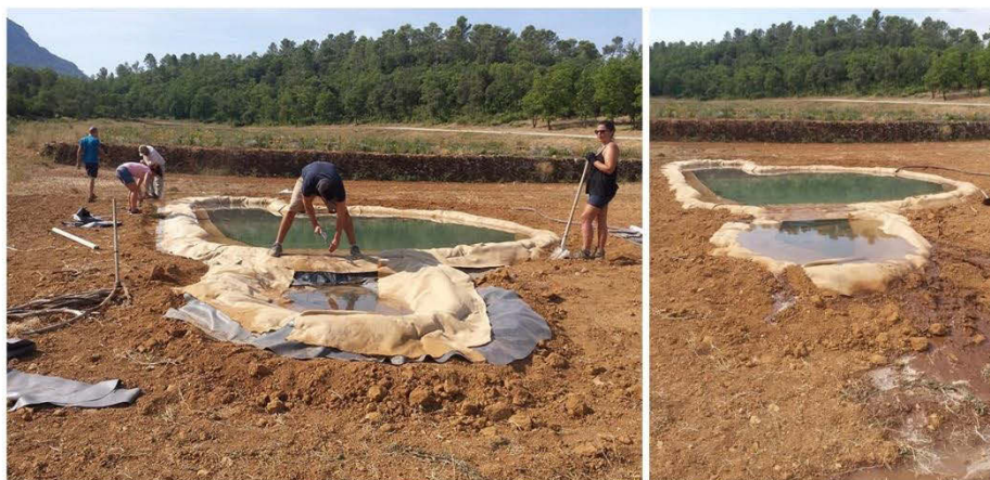
Et voilà, la végétation pourra recoloniser l'espace et la mare est prête à accueillir une riche biodiversité !
