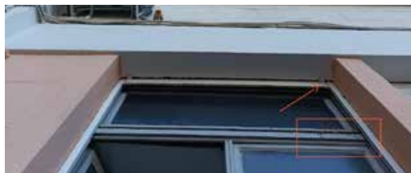
Coffrage de store occupé, bâtiment de l'Arsenal de Toulon, © Katherine DUBOURG
