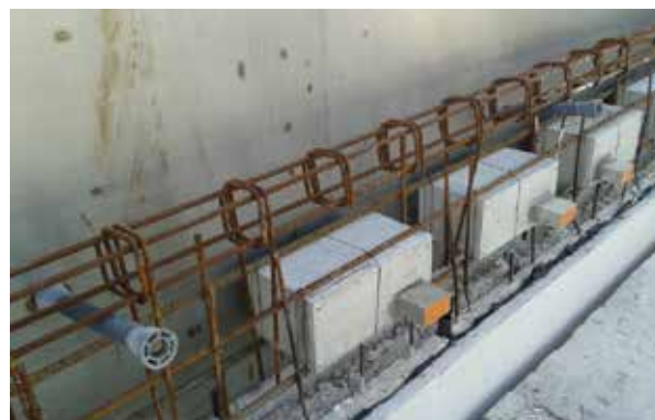
Nichoirs en béton de bois intégrés dans l'isolant du bâtiment, Nature Harmonie, Chalucet Toulon, © Katherine DUBOURG
