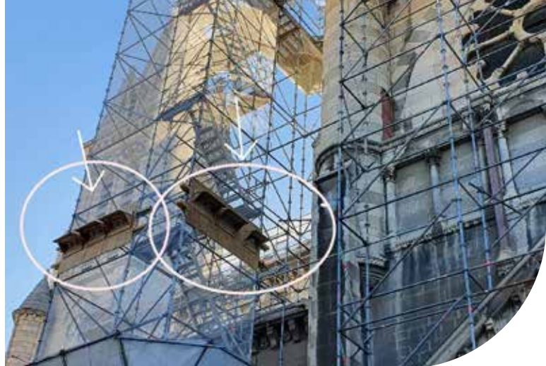
Nichoirs provisoires installés sur les échafaudages, Cathédrale St Arnoux, Gap, 2022, © Valérie VINCENT
