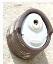
Nicher posé en excroissance sur un mur rénové © Elie Bardon
