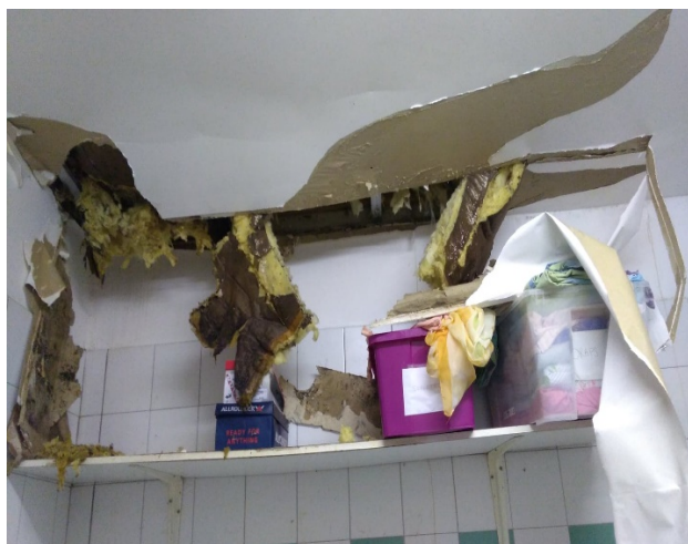
Effondrement du faux plafond de la quarantaine et nouvelle toiture ©Aurélie Amiault
