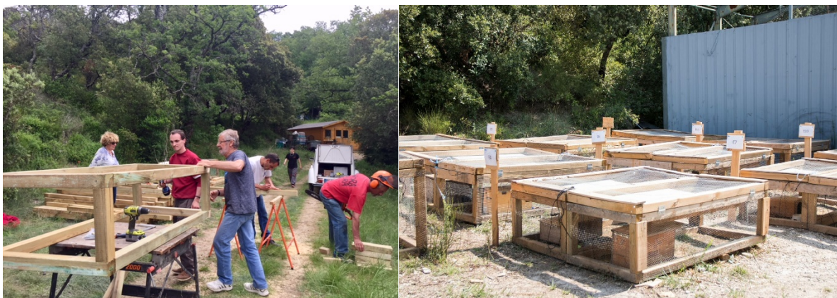
Chantier bénévole et cages terminées ©LPO Provence-Alpes-Côte d'Azur
