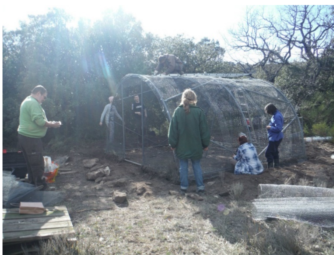
Remise en état d'une volière pour les corvidés ©Aurélien Amiault
